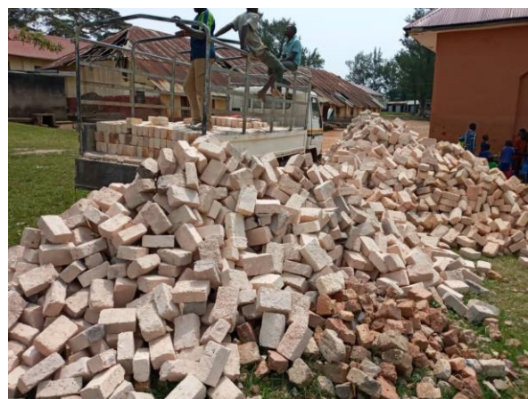
Het materiaal dat reeds is aangeschaft voor de verbouwing van de jongensslaapzaal
